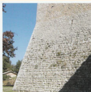
Particolari del coronamento superiore a sporgere e del basamento scarpato della torre leccetana.
